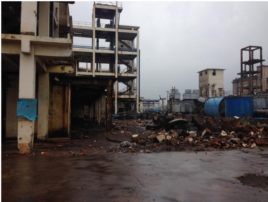
2. 原 HCFC-22 车间北侧
